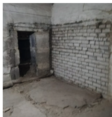
Kellerräume, für eine Renovierung vorbereitet
